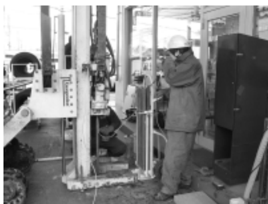
写真 3 MIP の挿入状況
