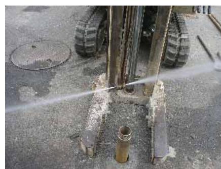
写真 5.2 F-ISCO(高圧噴射攪拌)
