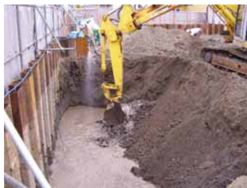
写真 5.1 フェントン反応剤の掘削攪拌処理
