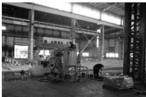
▲閉鎖した工場建屋内での原位置浄化
