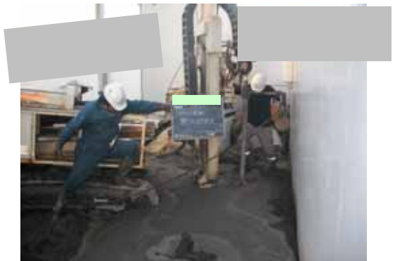
写真-3 工法 : 浄化状況
