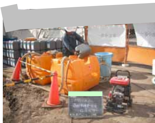
写真-4 工法 : 注入プラント
