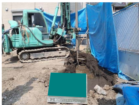
図 4 柱状改良機によるハイブリッド工法の施工状況
