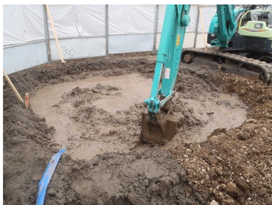
図 3 バックホウによる混合攪拌の施工状況
