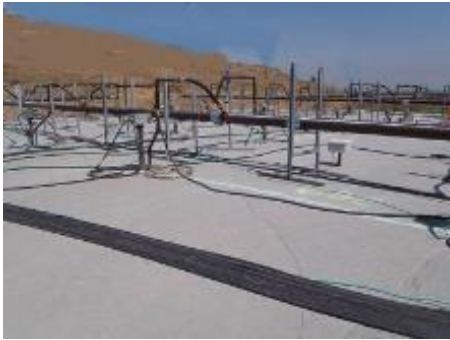
原位置熱脱着浄化中の現場
