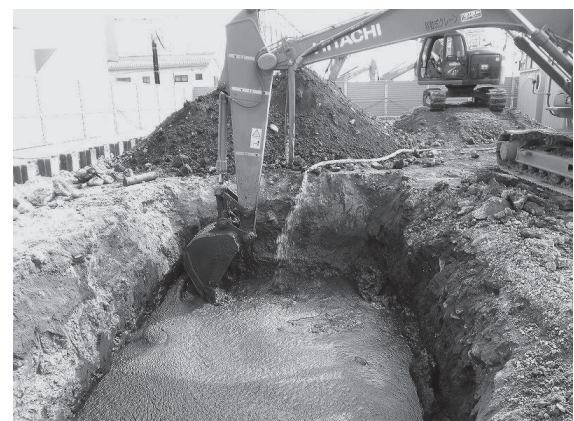
写真1 / バックホウによるフェントン反応剤の攪拌混合 施工風景
