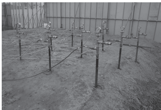
写真4 / ロッド注入の施工風景
