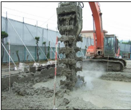
写真2. 重機を用いた原位置不溶化処理
