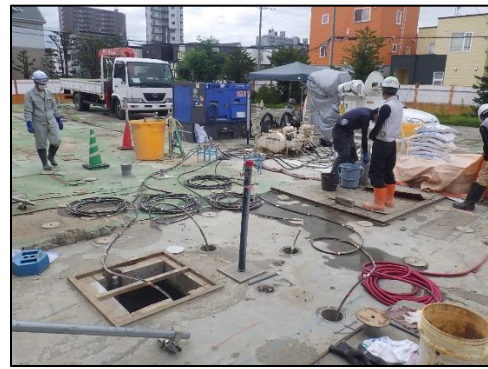
写真3. 不溶化材注入処理
